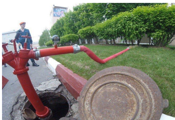
Рис. 3. Метод определения расхода с помощью показания манометра
