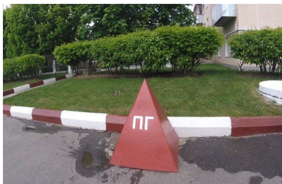
Рис. 1. Пожарный гидрант, расположенный на территории академии
