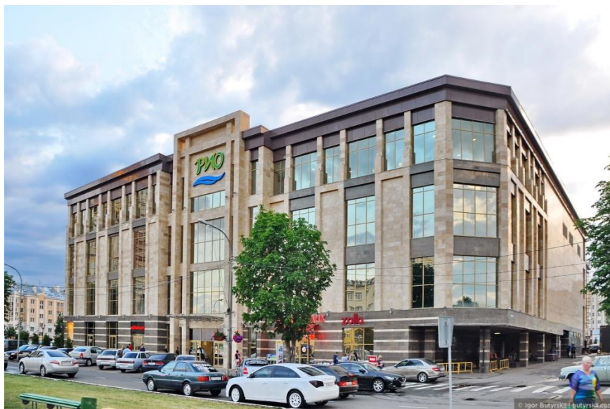
Рис. 1. Здание торгового центра «РИО»
