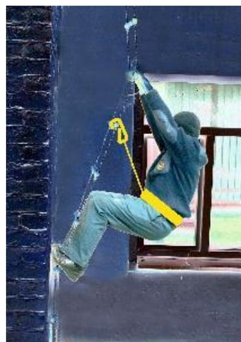
**Рис. 5.** Условная схема страховки при помощи пояса и фала с карабином
