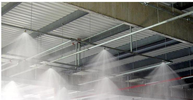
**Рисунок.** Спринклерные автоматические системы
