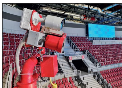
б) Пожарный робот ПР-ЛСД-С50У
