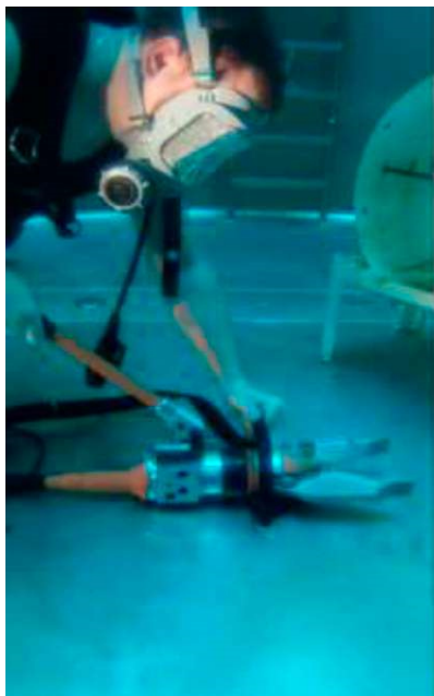
Рис. 4.6. Перекусывание арматуры при помощи РКГм 63.
