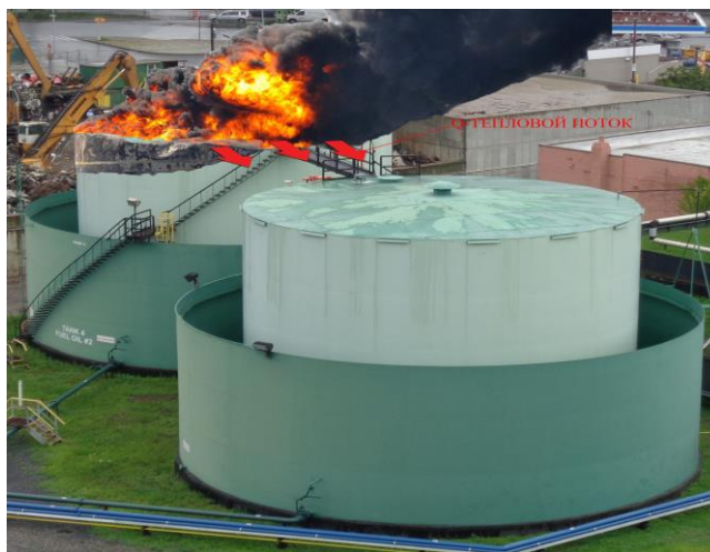
Рис. 1. Расчётная схема к определению пожарной опасности нагрева резервуара типа «стакан в стакане» [1]
