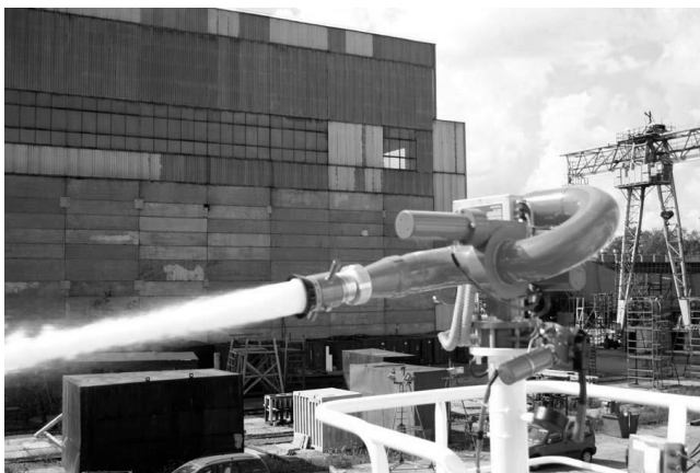
Рис. 1. Автоматизированный стационарный пожарный комплекс с установленным лафетным стволом
