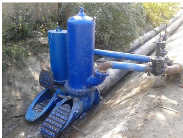
Рис. 1. Общий вид гидротаранной установки
