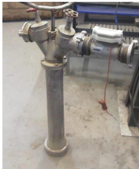
Рис. 2. Ультразвуковой расходомер на пожарной колонке
