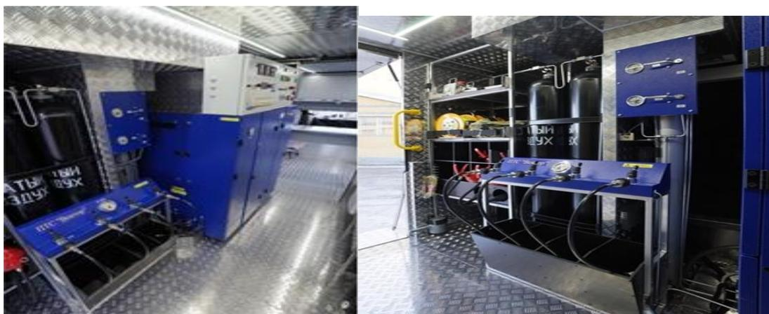
Рисунок 2. - Компрессорная установка ПТС «Вектор»-S-500Н
