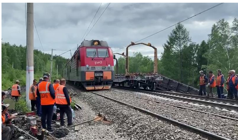
Рис. 4. Сход вагонов в Могочинском районе на перегоне Урюм-Нанагры Забайкальский край
