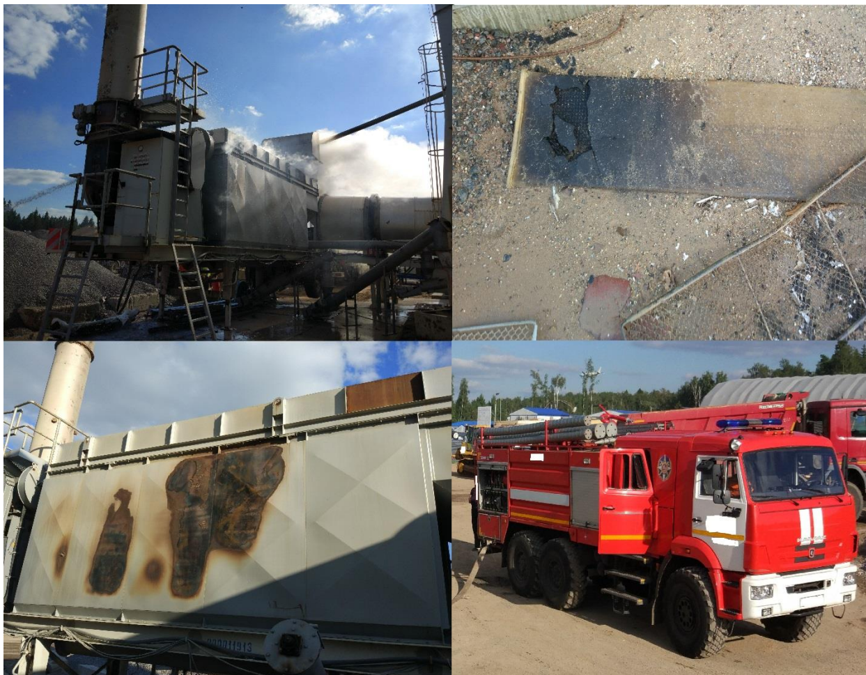
Рис. 1. Фильтровальная станции АБЗ, превышение пиковой температуры
