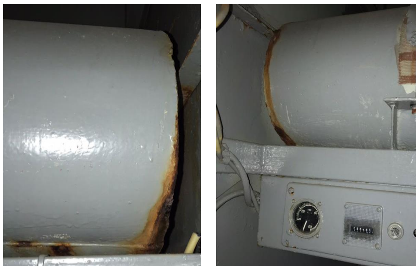
Рис. 1. Коррозия сварных швов бака пенообразователя автоцистерны пожарной ЗИЛ АЦ 3.2-40
