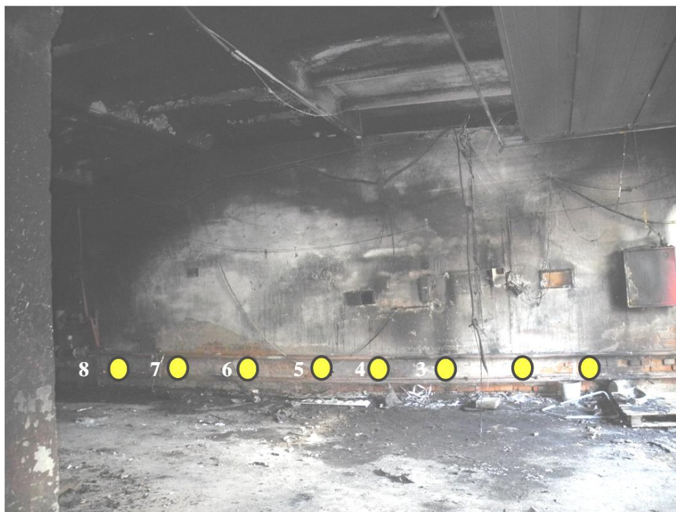
Рис. 2. Схема мест замеров значений коэрцитивной силы
