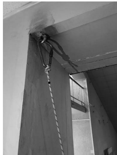
Рис. 4. Крепление «рым-гайки (DIN 582) M24»
