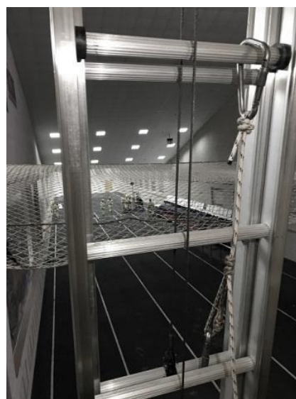
Рис. 7. Фиксация 2-го и 3-го колен лестницы схватывающим узлом «Пруссика»
