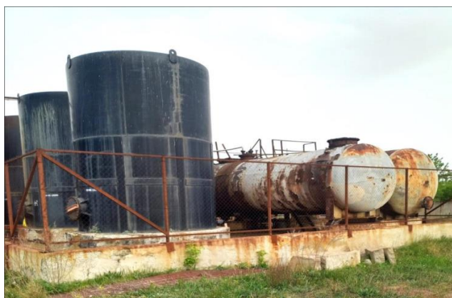
Рис. 1. Стационарные танк-контейнеры с серной кислотой на территории завода «Коагулянт»
