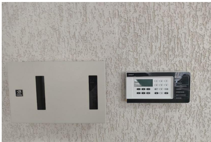
Рис. 1. Блок питания «БП-12/2» и контроллер «Панель-2-ПРО»
