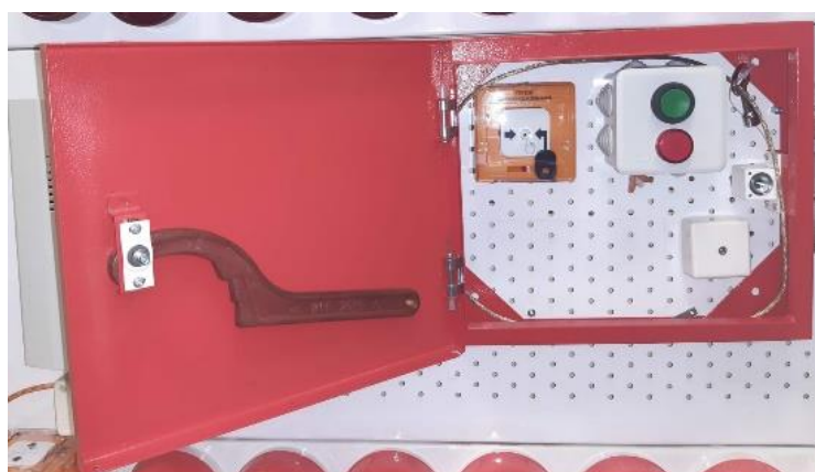
Рис. 3. Установка запорного устройства «МИВ-3» или «МИВ-3» (исп. 01) и пломб-свидетелей
