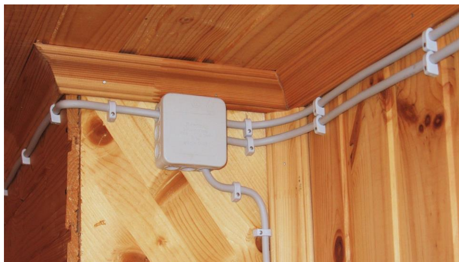
Рис. 2. Открытая проводка
