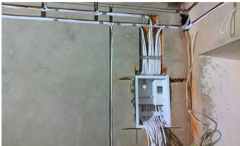
Рис. 1. Скрытая проводка
