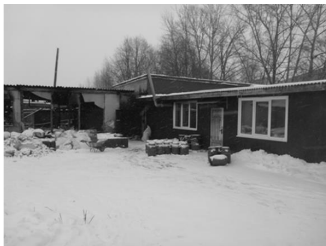
Рис. 1. Юго-западная сторона здания склада и здания швейного цеха
