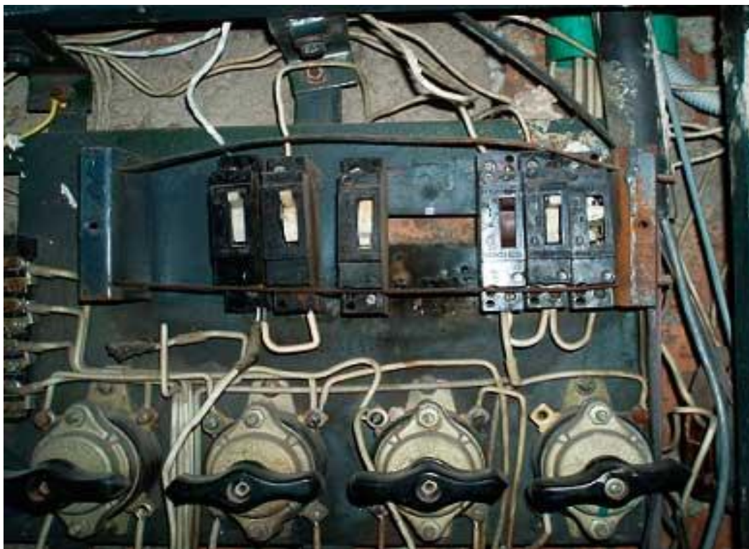
Рис. 3. Старая алюминиевая проводка
