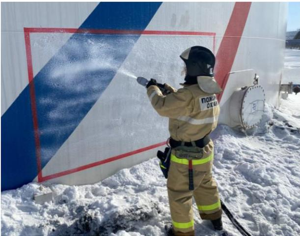
**Рис. 2.** Нанесение гидрогелевого покрытия на стенку резервуара
