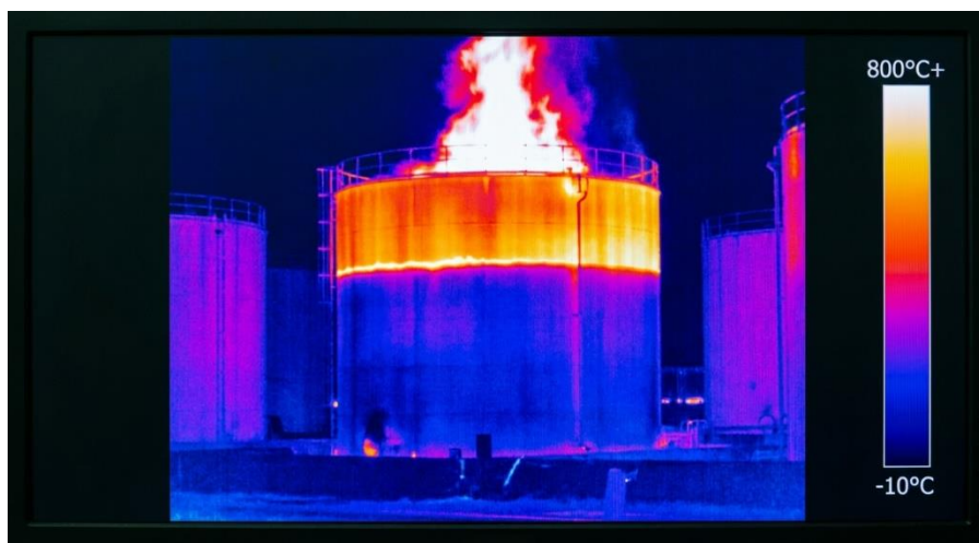
Рис. 2. Термограмма вертикального стального резервуара РВС-5000 в начальной стадии пожара: визуализация границы горения и прогрева стенок
