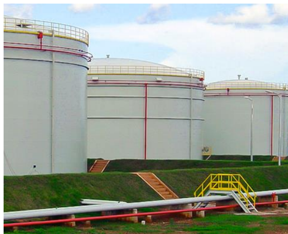
Рис. 2. Общий вид типовых ограждений РВС в виде грунтового обвалования (слева) и ограждающей стены из железобетонных блоков
