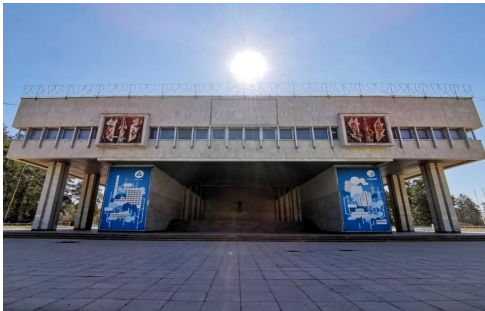
Рис. 1. Фасад здания НКЦ имени Славского
