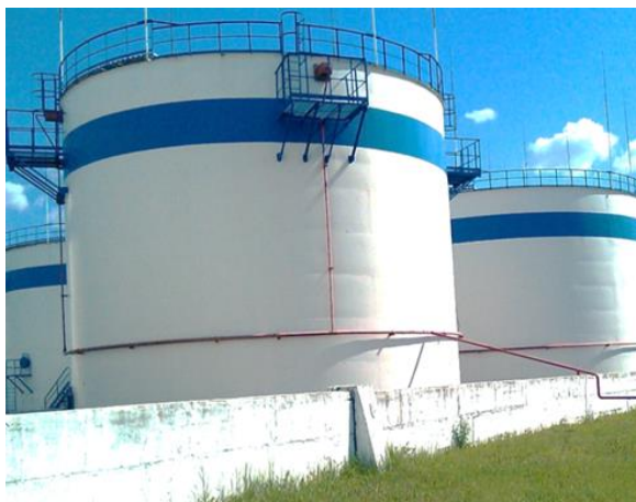
Рис. 2. Общий вид типовых ограждений РВС в виде грунтового обвалования (слева) и ограждающей стены из железобетонных блоков
